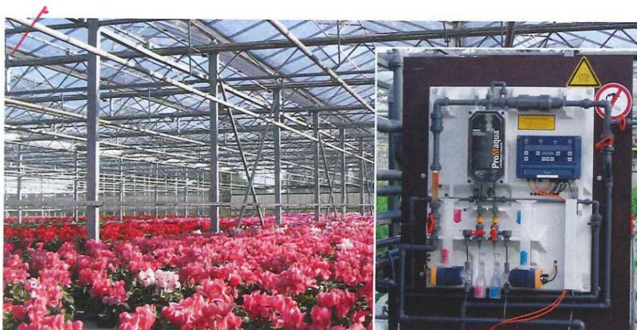
Anschlussfertige, komplette Chlordioxidanlagen Bello Zon® CDVc zur Herstellung, Dosierung und Überwachung von 20 bis 2.000 g/h Chlordioxid (ProMinent)
